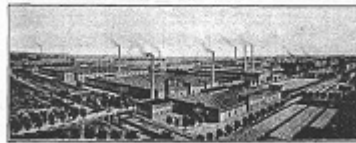
Die frühesten Fabrikanlagen.
