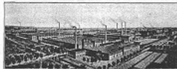
Die frühesten Fabrikanlagen.
